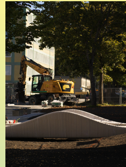
LOKALT: Den nye broen ble 3D-printet i et telt like utenfor Sentralbygget. Foto: Statsbygg
